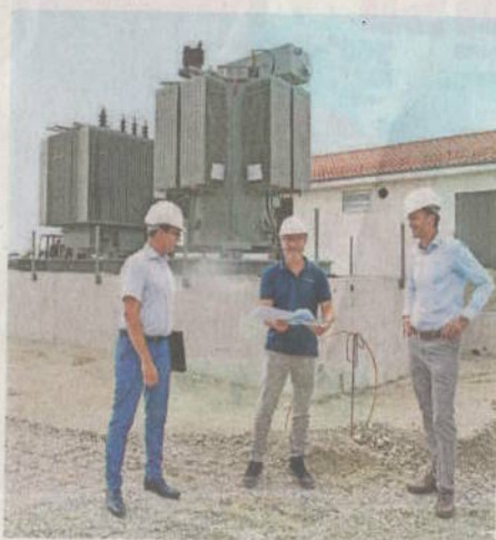
Stadtwerkechef Thomas Grulke, Thomas Riederer und Karlheinz Denner vom Bayernwerk (von links) auf der Baustelle für das neue Umspannwerk der Stadtwerke Olching nahe der Bundesstraße 471.
